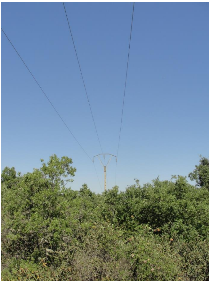
Figura 3. Línea eléctrica 45 KV a su paso por el monte/Fuente: archivo propio
