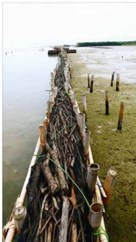
Foto 2: Sedimentatie achter doorlatende dammetje dat hopelijk de kustlijn kan herstellen (Foto van Wetlands International Indonesia).
