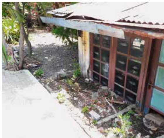
Foto 7: Bij de oude haven van Semarang daalt de bodem t.g.v. zoetwater onttrekking en komt de opgehoogde weg tot aan de vensterbank van een huis.
