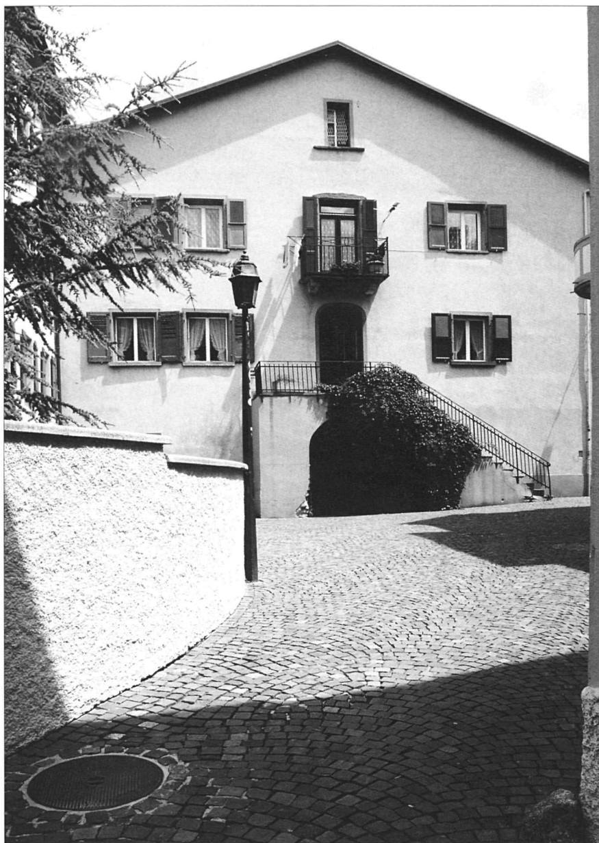
Abb. 7: Das so genannte Theilerhaus (1264 errichtet), die ehemalige Suste in Brig am Fusse des Simplonpasses, vermochte im 14. Jh. mehrere Tausend Warenballen aufzunehmen
