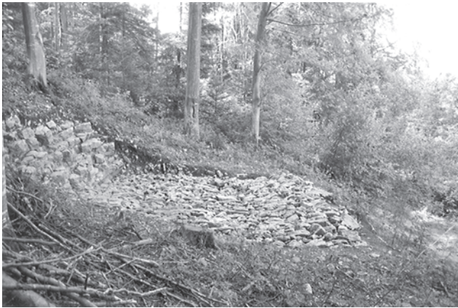
Fig. 58 Asuel, Les Rondins. Vue de la chaussée romaine en direction de l'ouest. Les rochers à gauche ont été entaillés pour la construction de la route.
