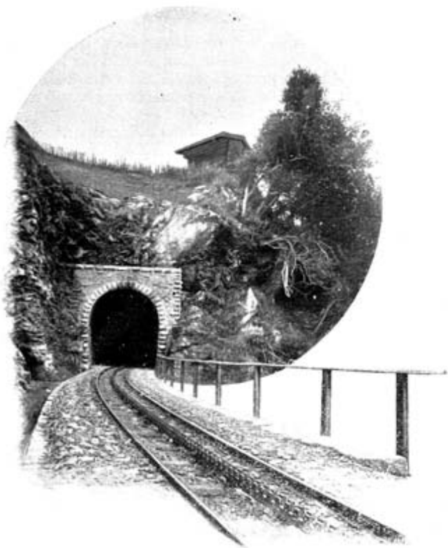
TUNNEL DU CHEMIN DE FER DE ZERMATT
