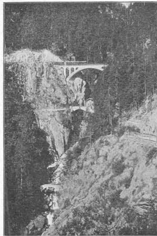
VALLÉE DU TRIÈGE (PONT DU TRIÈGE)
