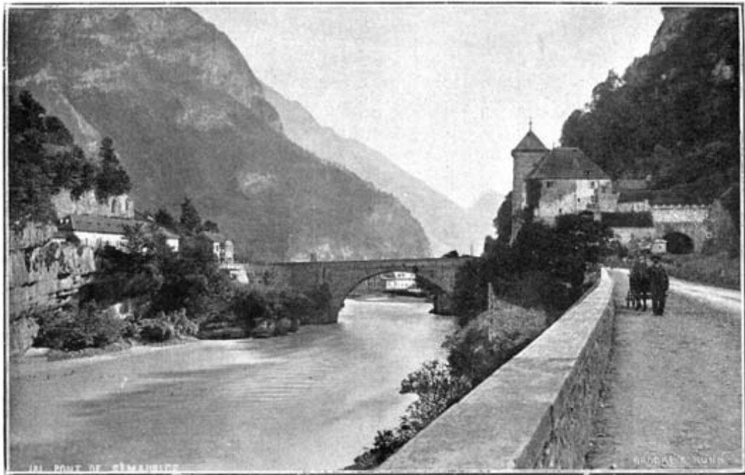
PONT DE SAINT-MAURICE
