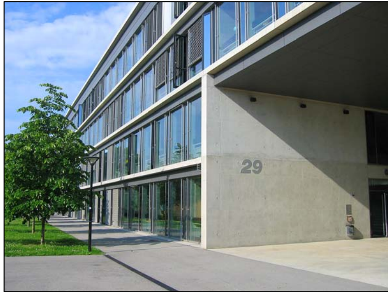
Façade avant du COMO (21.05.2007)
