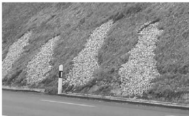
Fig. 7.2. «Fenêtres» de fonte artificielles au bord de la route Marly – Le Mouret (FR) (670 m.s.m.). Des drains sont posés sous les graviers et sont reliés au réseau d'évacuation des eaux. L'air s'y écoule de la même manière que dans un réseau karstique ouvert. La première photo date de la période très froide de février 2003. (Photos : M. MONBARON, février-mars 2003)
