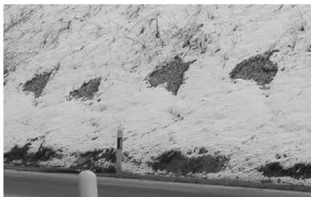
Fig. 7.2. «Fenêtres» de fonte artificielles au bord de la route Marly – Le Mouret (FR) (670 m.s.m.). Des drains sont posés sous les graviers et sont reliés au réseau d'évacuation des eaux. L'air s'y écoule de la même manière que dans un réseau karstique ouvert. La première photo date de la période très froide de février 2003. (Photos : M. MONBARON, février-mars 2003)
