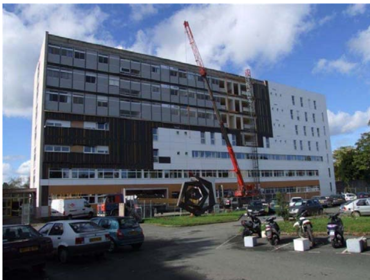
Figure 26 : rénovation du lycée Pavie à Guingamp par Turmel : pose des panneaux à ossature bois en cours
