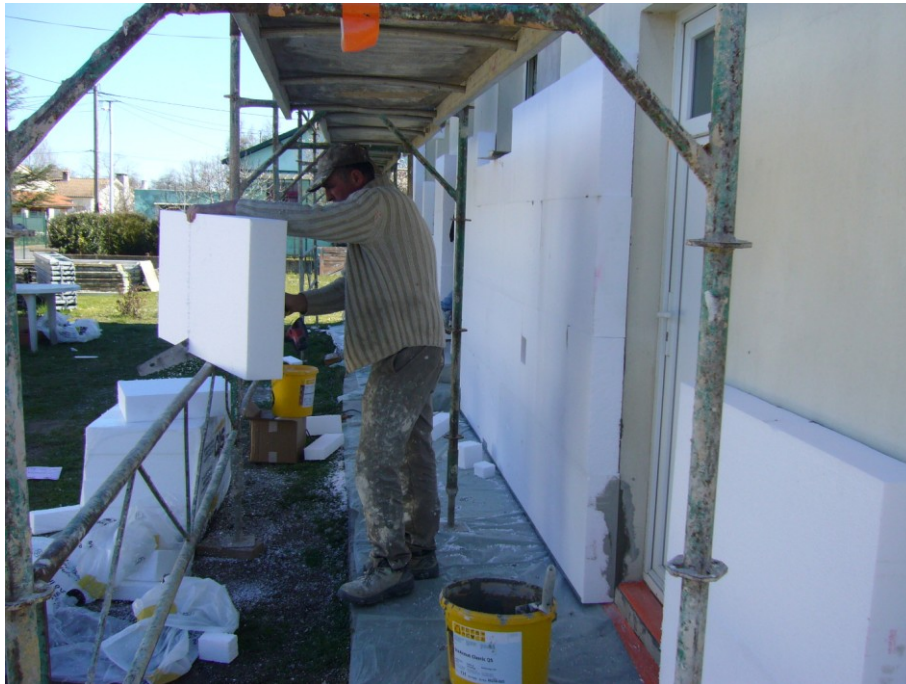
Figure 11 : chantier d'isolation par l'extérieur d'une maison individuelle en banlieue de Toulouse en 2010
