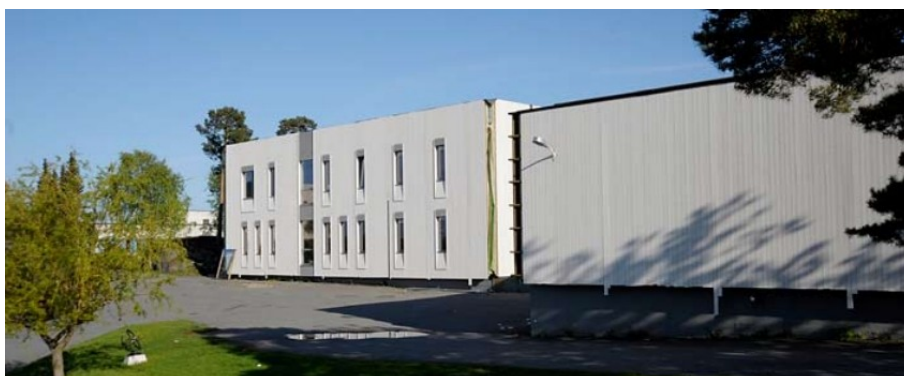
Figure 22 : collège technique à Risør en Norvège avant et après rénovation par Trebyggeriet AS
