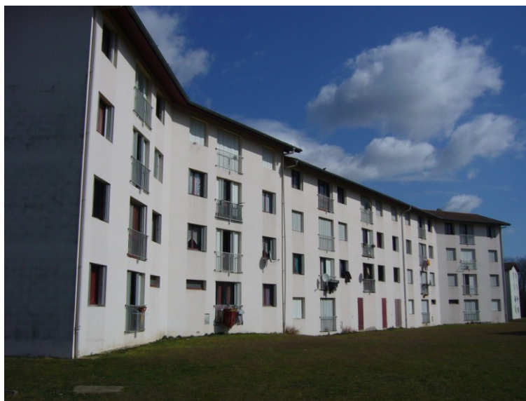
Figure 50 : exemple de façade à rénover
