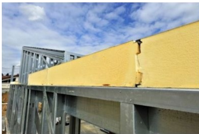
Figure 30 : exemple de panneau sandwich acier/mousse polyuréthane
