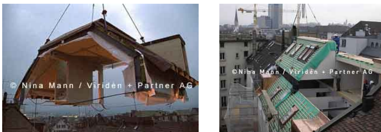
Figure 17 : exemples de réalisations de Viridén + Partner AG avec pose de toitures préfabriquées
