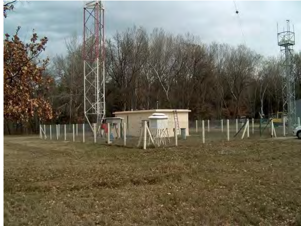
Fig 1-63 : Pylône météo et son local technique (site CEA Cadarache)
