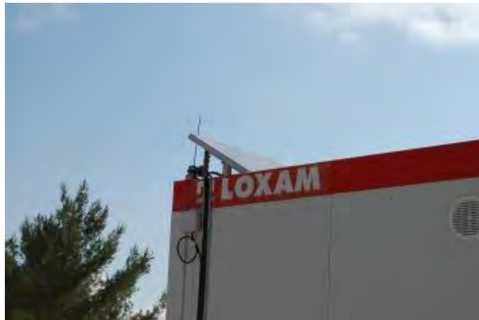
Fig 5-83: Panneau photovoltaïque en court circuit pour relever l'éclairement
