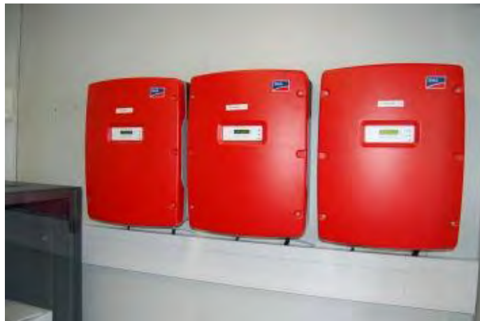
Fig 5-85: Installation des onduleurs SMA en triphasé
