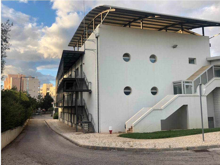
Figura 21. Fachadas lateral e traseira do Departamento de Engenharia Civil.
