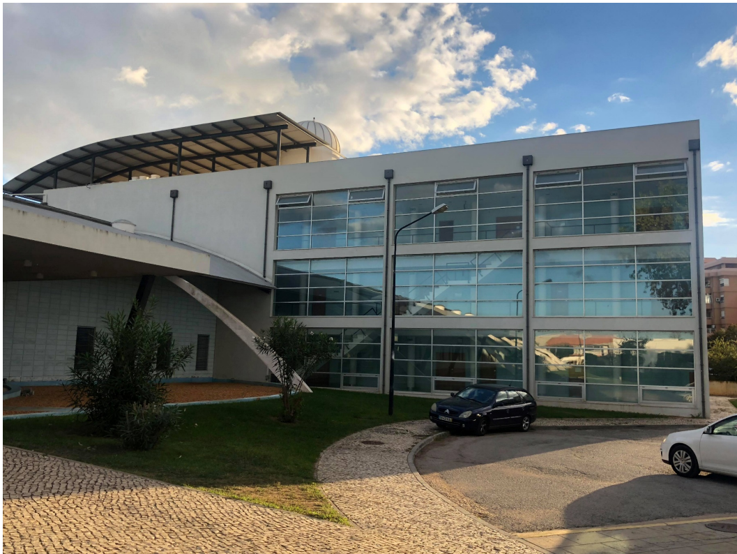
Figura 20. Imagem fachada principal do Departamento de Engenharia Civil.
