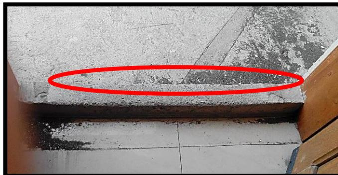
*Figura 37. Muro que impide la entrada de agua*
