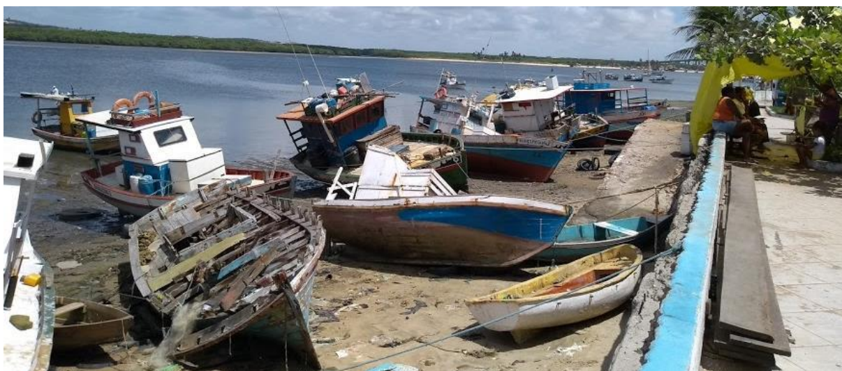
Figura 6: Registro fotográfico da área de construção do berço 4
