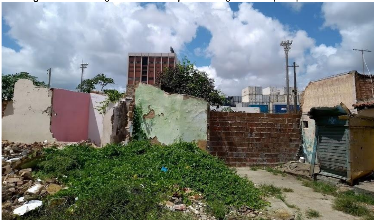
Figura 20: Imagem 1 das demolições na antiga área ocupada pela comunidade
