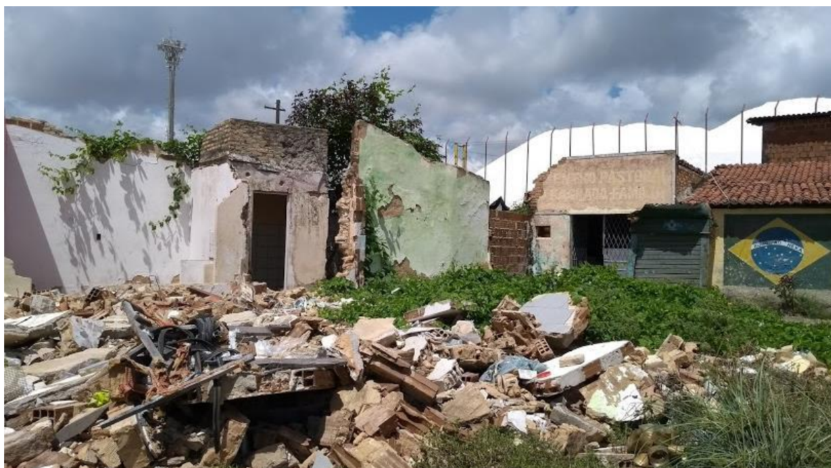
Figura 21: Imagem 2 das demolições na antiga área ocupada pela comunidade
