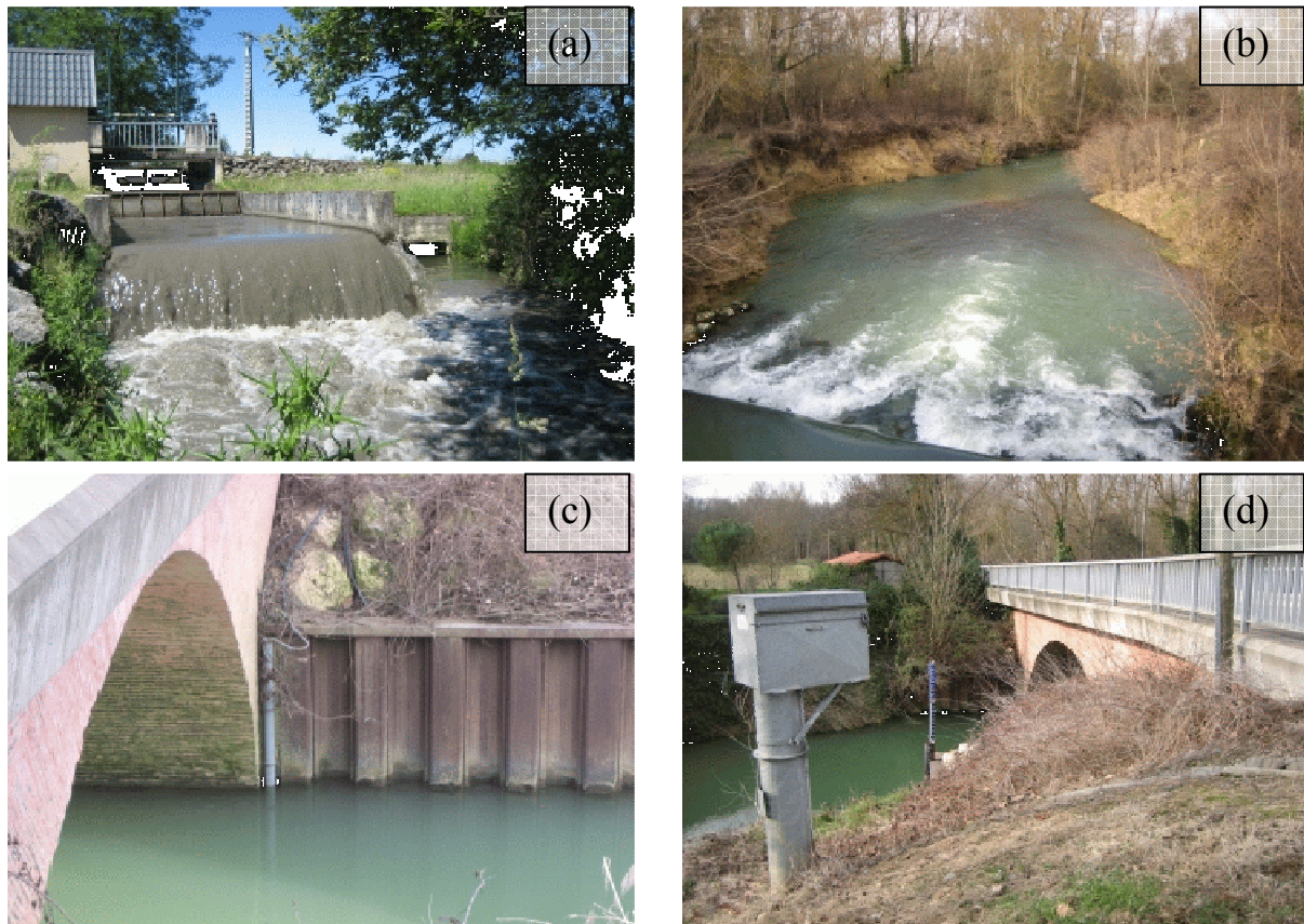
Figure 8. La Save : (a) jonction entre Neste (à gauche) et le ruisseau de la Save (à droite) à Lannemezan, (b) seuil de l'exutoire à Larra, (c) sonde reliée au préleveur automatique à l'exutoire et (d) hydrographe et règle de la Compagnie d'Aménagement des Coteaux de Gascogne à l'exutoire.
