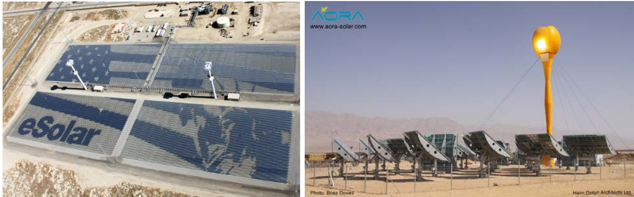
(a) Centrale Sierra SunTower de 5 MW à Landcaster - Californie (construite et exploitée par eSolar)
