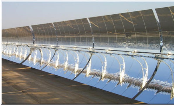
(a) Concentrateurs cylindro-paraboliques.
