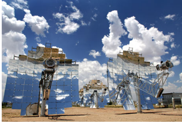
FIGURE 1.5 – Ferme solaire au États-Unis avec les machines SunCatcher fabriquées par Stirling Energy Systems (SES)
