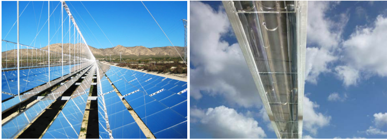
(a) Champ de miroirs construit par Novatec Biosol (b) Récepteur avec vitre, tube absorbeur, et second concentrateur. (Source : CNIM)
