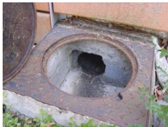
Figure II-28. Sortie d'un collecteur d'eaux pluviales du site 2
