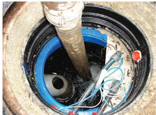
Figure II-37. Vidange de la cuve sur le site 2
