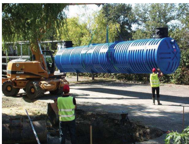
Figure II-31. Installation de la cuve sur le site 2
