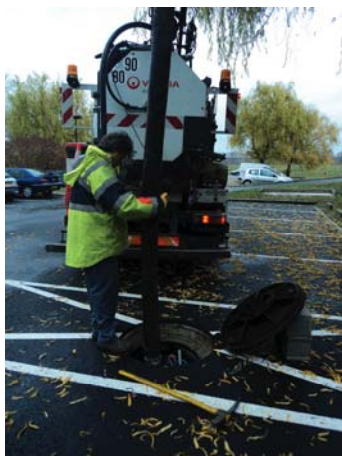
Figure II-36. Camion hydrocureur sur le site 2
