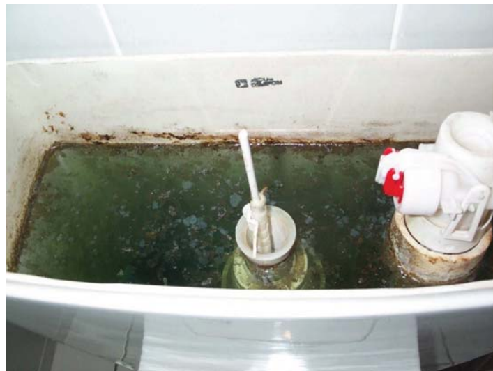
Figure IV-16. Contamination du système par un biofilm en été sur le site 2
