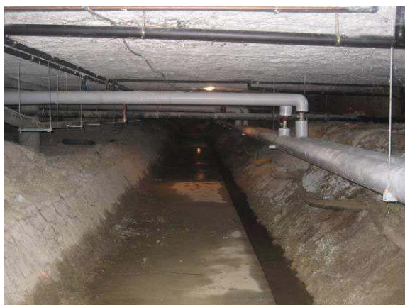
Figure II-27. Vide sanitaire du site 2
