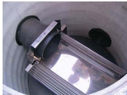
Figure II-43. Lieu de prélèvement d'eaux de ruissellement de toiture sur le site 2
