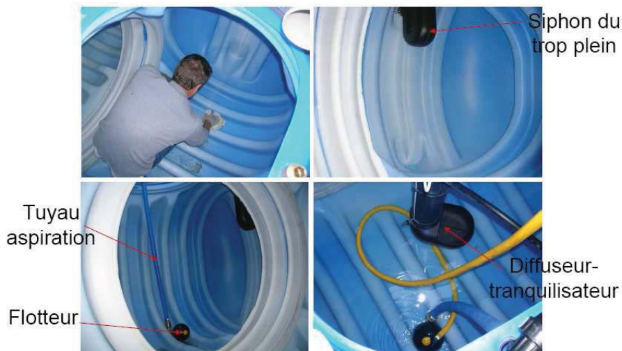
Figure II-14. Intérieur de la cuve du site 1
