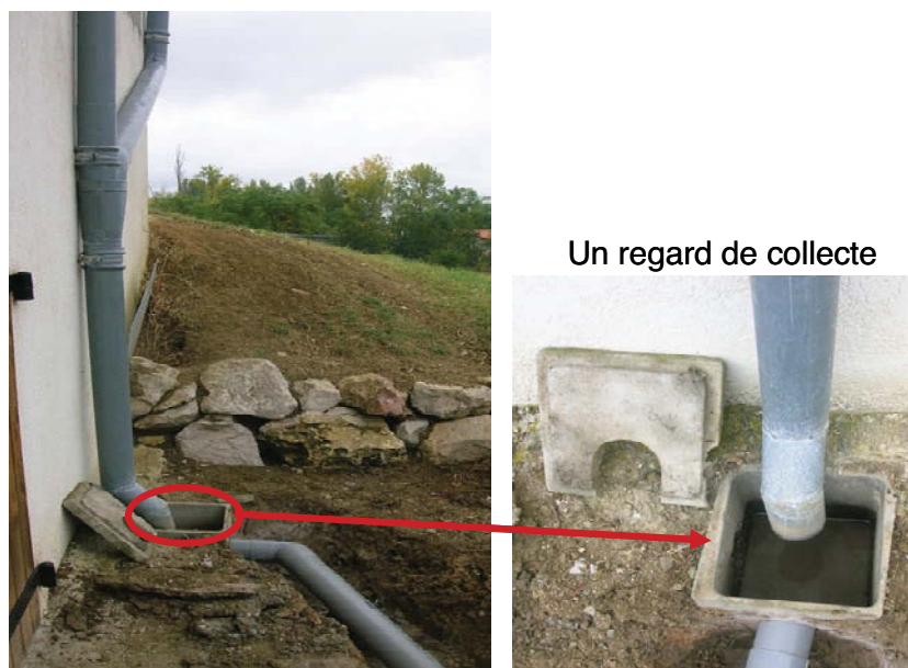
Figure II-9. Une des quatre descentes pluviales du site 1
