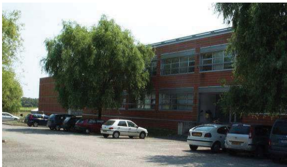
Figure II-22. Site 2 : Bâtiment collectif
