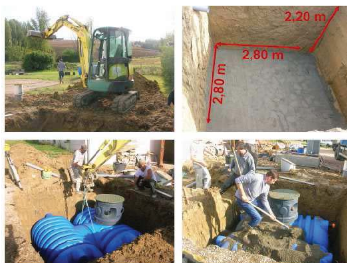
Figure II-11. Mise en place de la cuve enterrée sur le site 1
