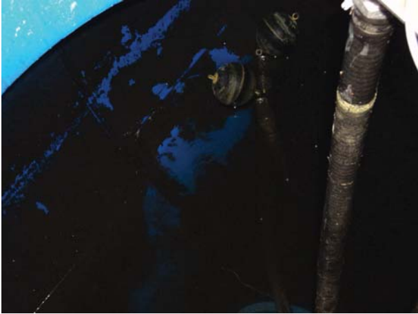
Figure II-38. Sédiments au fond de la cuve sur le site 2
