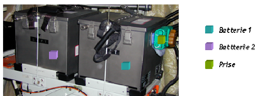
figure I.9 : installation de batteries sur un A380
