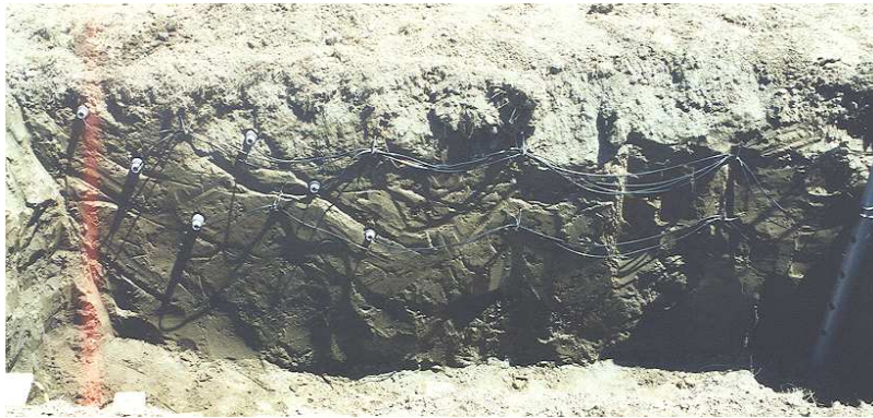
FIG. 3.4 – Détail de la fosse avec les capteurs d’humidité aux différentes profondeurs. (Photo F. Marty 2002)
