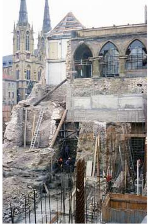
En août 1976 : reprises en sous-œuvre 10 m en dessous de la cour du Carmel (arcades) et 3 m sous les fondations du rempart.
