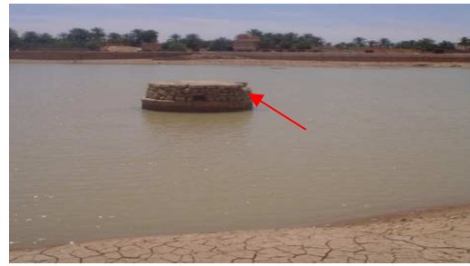
Photo 4 : Puit capteur du barrage Bouchène
