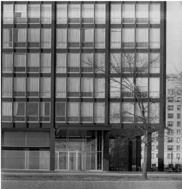
1.2.3.- Detalle de las carpinterías de acceso del Federal Center de Chicago (1959-1964) donde se aprecia la manipulación del módulo de carpintería contiguo a la estructura.
