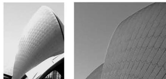
2.9.5.- Muestras de piezas cerámicas con los dos acabados. Utzon se inspiró del color de la porcelana Ming y con Höganäs distinguió una pieza más brillante mediante la inclusión de "chamota" en la pasta de una forma irregular. Las fotografías muestran como según la incidencia del sol la junta aparece más clara o más oscura que la base.
