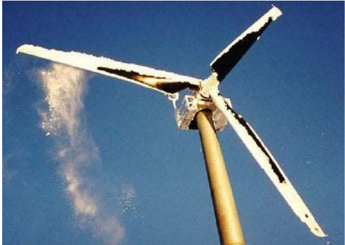
Figure 2: Pales d'éolienne peintes en noir givrées.
