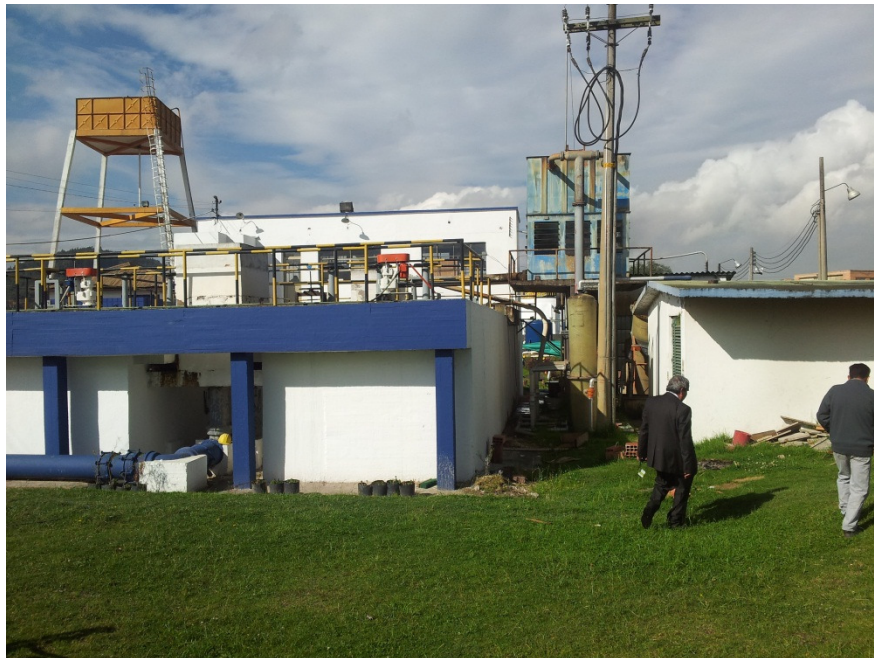
Vista General de la PTAP
