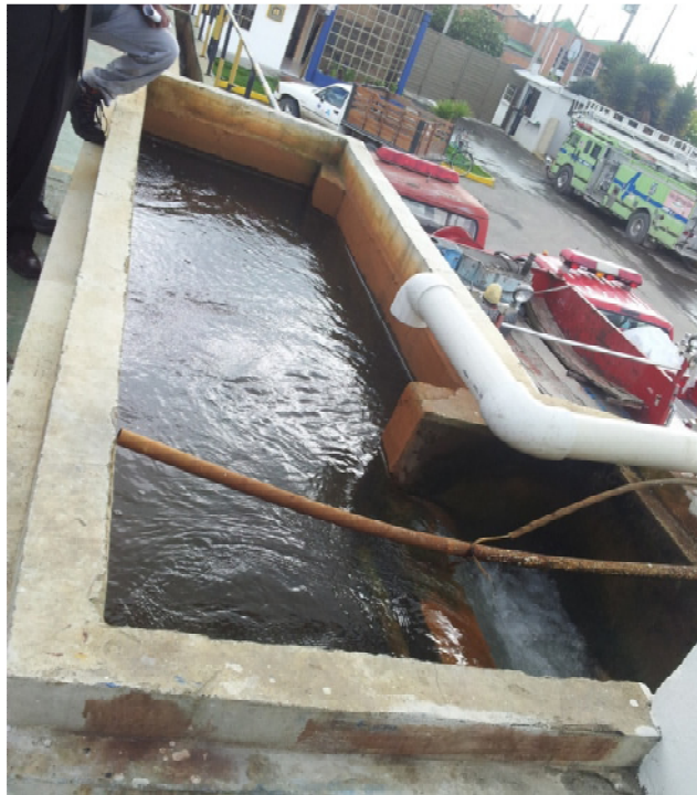
Punto de mezcla
