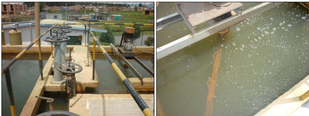
Figura 7-5. Floculador Mecánico.
