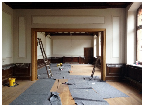
Abbildung 8 Professoren- und Konzilzimmer während der Restaurierung
