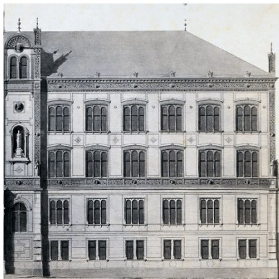
Abbildung 15 Hauptgebäude Hauptfassade rechts vom Mittelrisalit
