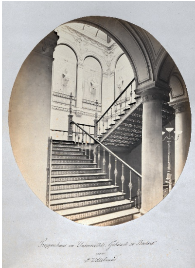
Abbildung 24 Hauptgebäude Haupttreppe vom 1. zum 2. Obergeschoss 1870
