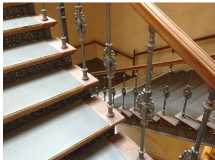
Abbildung 6 Das gusseiserne Treppenhaus
