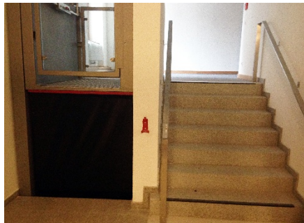
Abbildung 15 Zugang zum Flügelanbau
