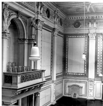
Abbildung 10 Aula mit alten Leuchtern nach 1937
