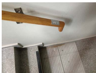
Abbildung 1 Taktile Beschriftung des Handlaufs des Geriffeltes Fußbodens vor der Treppe
