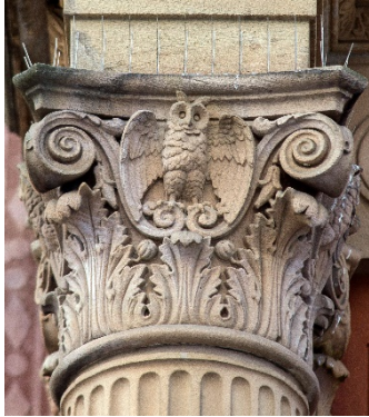
Abbildung 11 Kapitell der Portalsäule am Hauptgebäude
