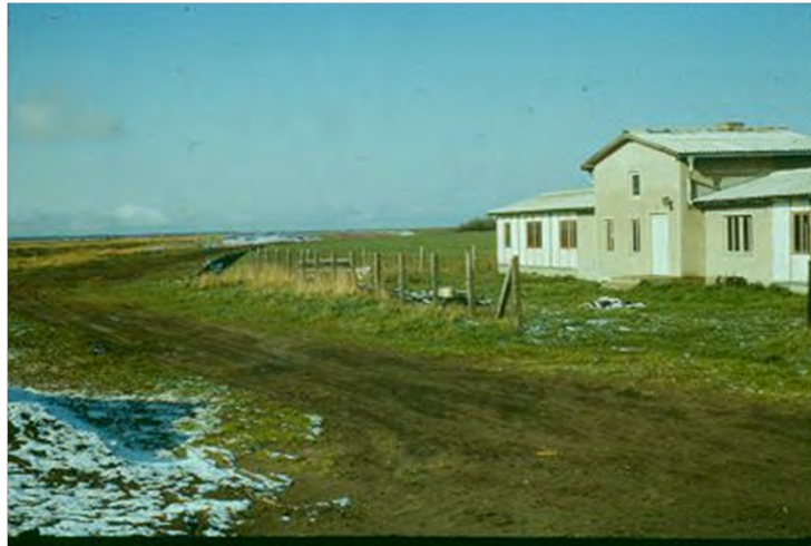
Winter 1977/78: Die Station ist fast fertig. Das Grundstück hinter dem Deich am Dorfrand ist noch naturbelassen. (Foto: Henning Baudler).
