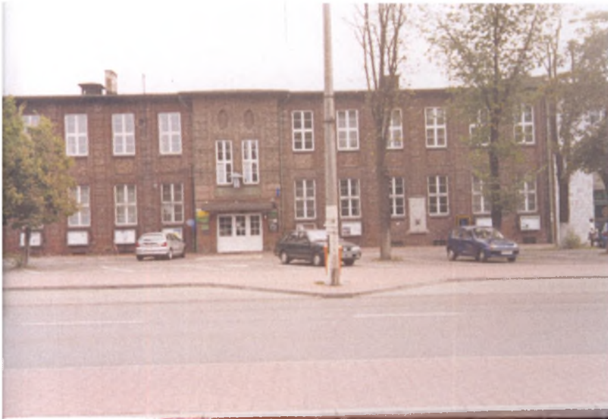
Fot. 4. Budynki dyrekcji KWK Wieczorek (dawniej kopalni Giesche), tu pracował Franciszek Pilarek
