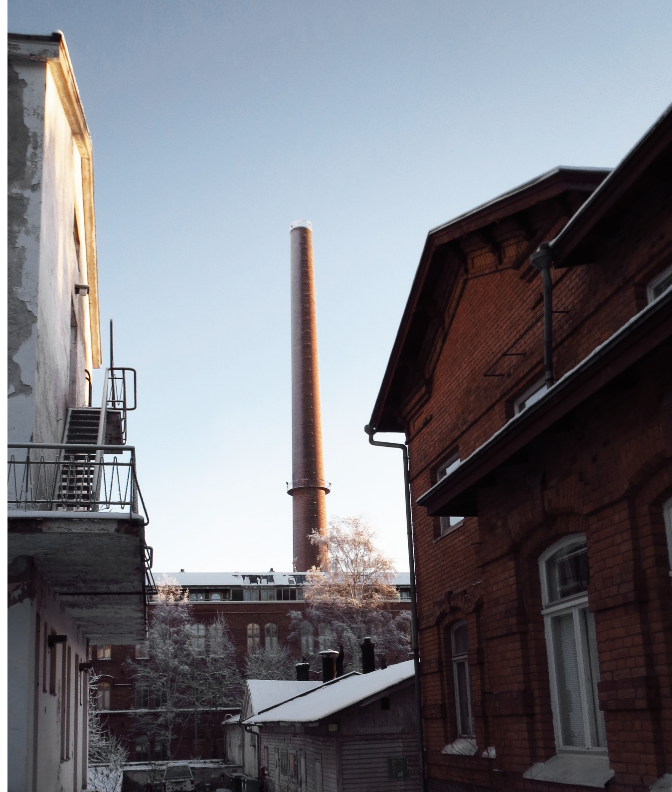
Kuva 14. Vasemmalla säilytettävä vanha kulkutautisairaala, oikealla säilytettävä punatiilinen rakennus, 1893, joka toimii tällä hetkellä Pirkanmaan musiikkiopiston harjoitustilana. Taustalla Klingendahl sekä purettava vanha lämpökeskus
