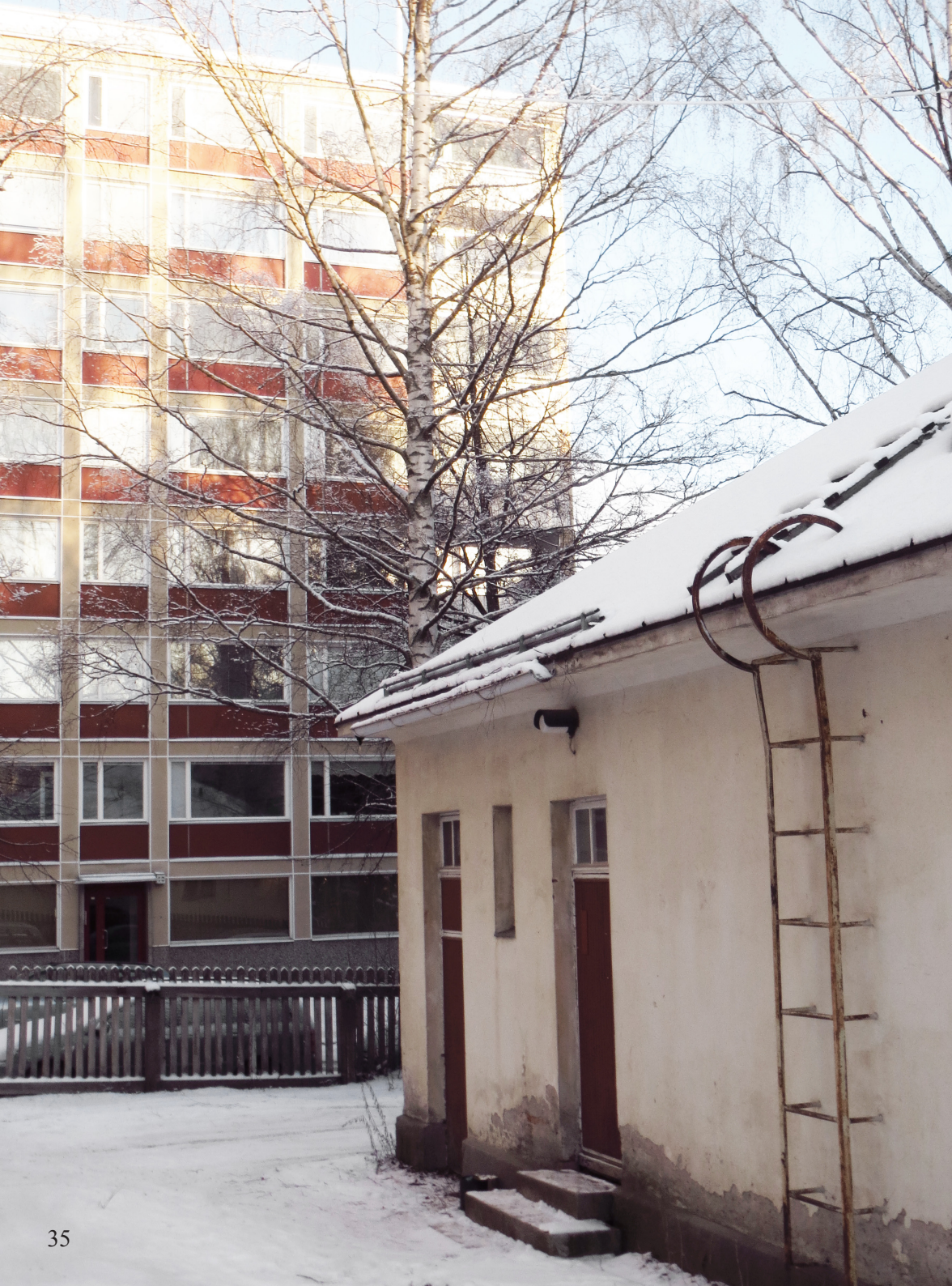
Kuva 16. Säilytettävä rakennus, vanha sauna, vuodelta 1952
