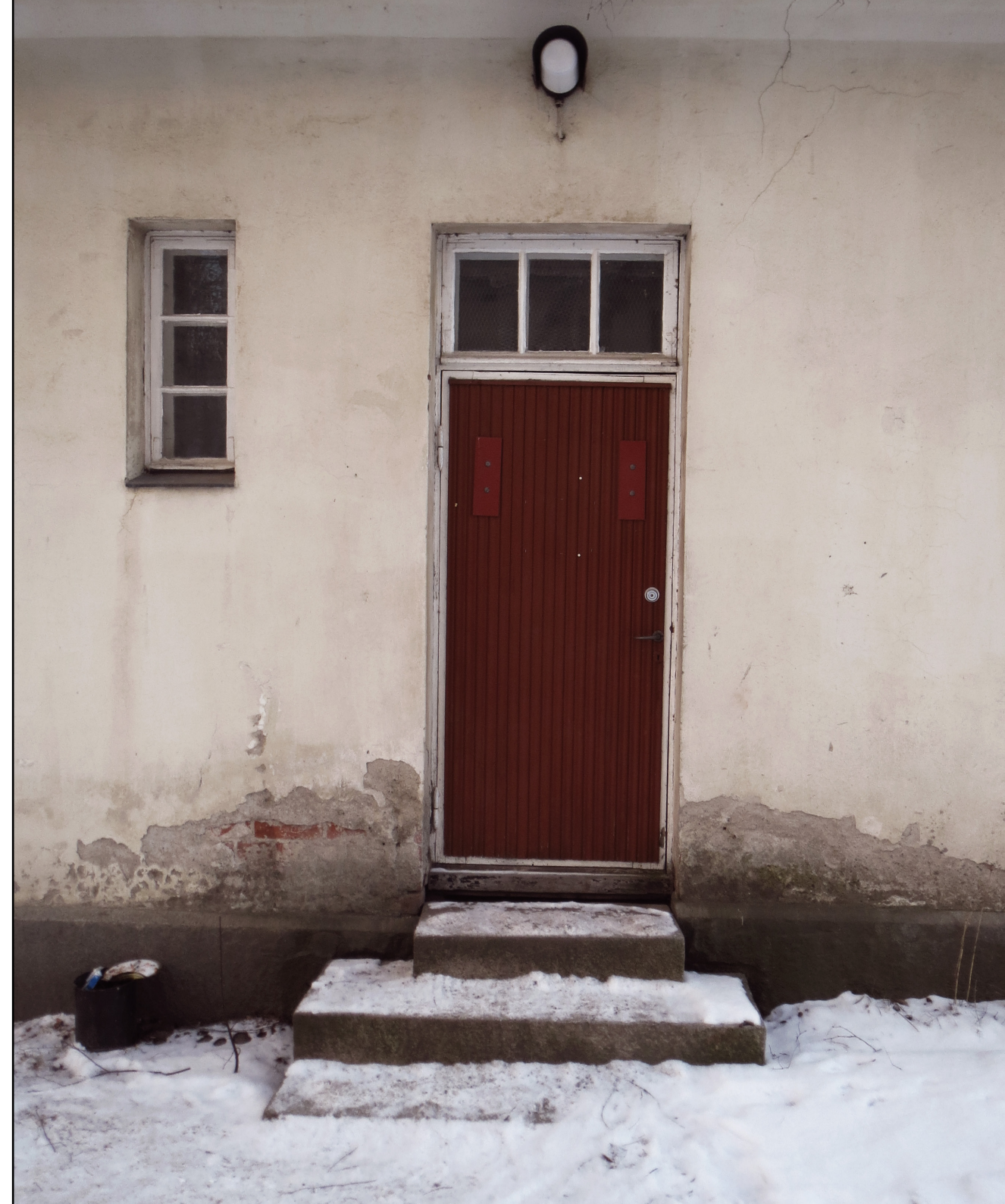
Kuva 34. Säilytettävä rakennus, vanha sauna, vuodelta 1952
