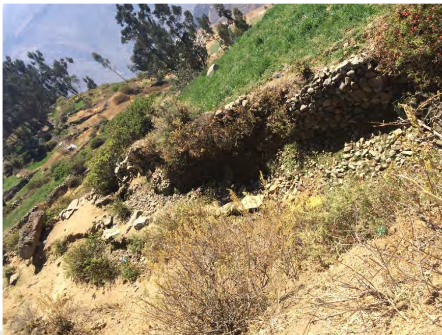
Fotografía N°13: Huancacequia. Fotografía de Lesly Barriga.
