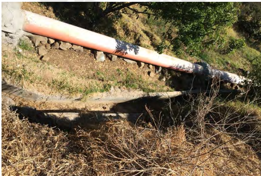
Fotografía N°15: Canal entubado a Matoca-Santil (al lado, canal antiguo). Fotografía de Lesly Barriga.
