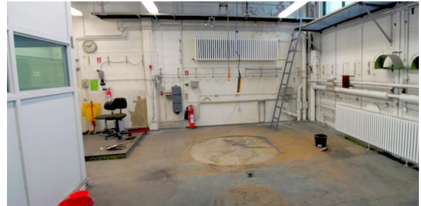
Bild 20: Nach dem Rückbau
