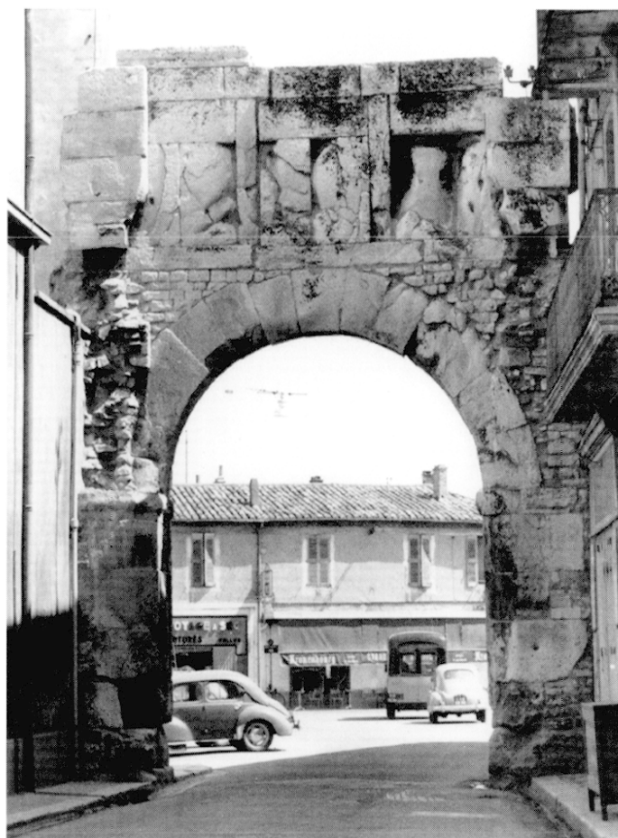
Fig. 5 – Face postérieure de la porte de France en 1959 (photo musées de Nîmes).
