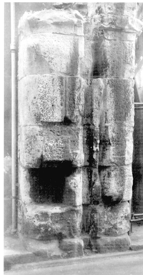
Fig. 12 – Tableau du piédroit est de la porte de France, avec cavité en \Gamma permettant la mise en place de la barre horizontale ; l'un des blocs de l'assise immédiatement inférieure est incomplet (photo P. Varène, CNRS).
