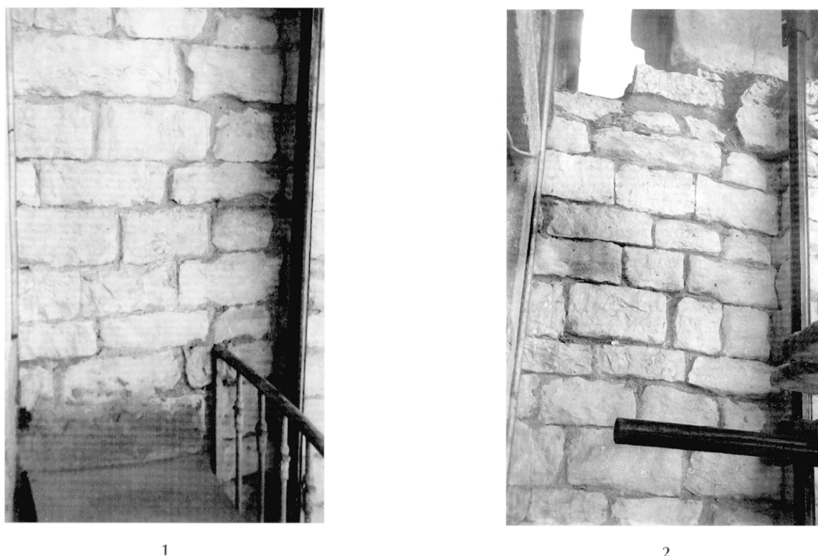
Fig. 17 – Détails du parement de moellons de la porte de France montrant la variété de leurs dimensions et de leur format : 1, façade côté ouest, au-delà de l'avant-corps ; 2, immédiatement au-dessus de la photo précédente (photos P. Varène, CNRS).
