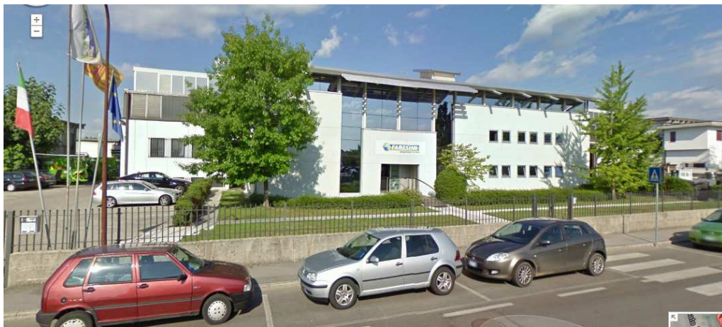
Figura 2.4: la sede centrale.
