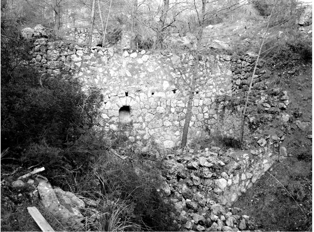
Fig. 4 Finestra de la tremuja dels forns de guix inferiors de les mines de les coves del Pilar (Palma). Per sobre, es poden observar els encastaments de les bigues. Fotografia realitzada el 28-01-2013
