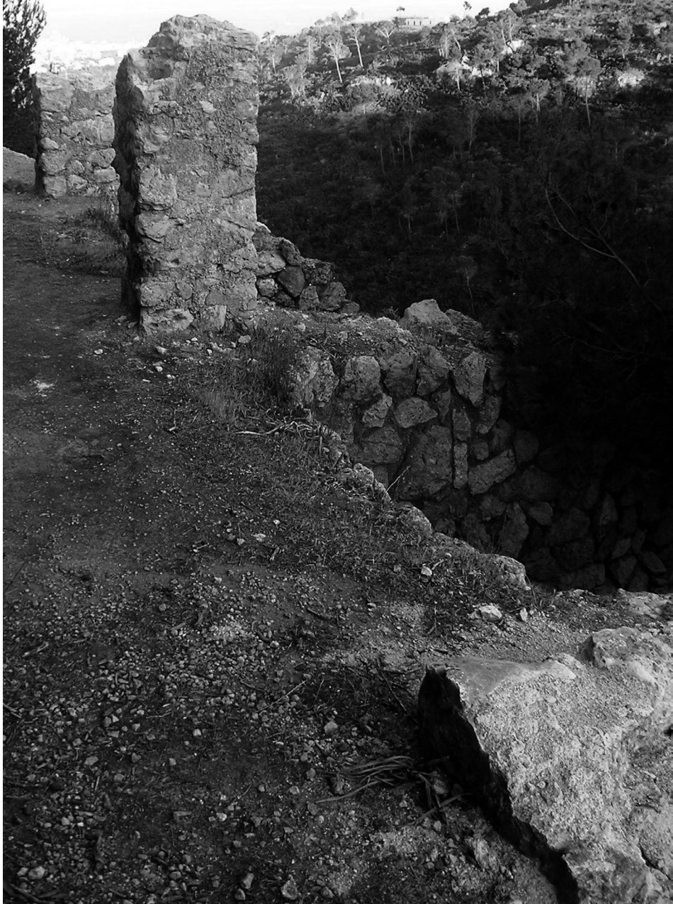
Fig. 2 Fornes de guix superiors de les mines de les coves del Pilar (Palma). A la fotografia es poden observar les restes de les tres columnes posteriors dels forns. De la columna que hi ha en primer terme, només en queda la base. Fotografia realitzada el 07-06-2005
