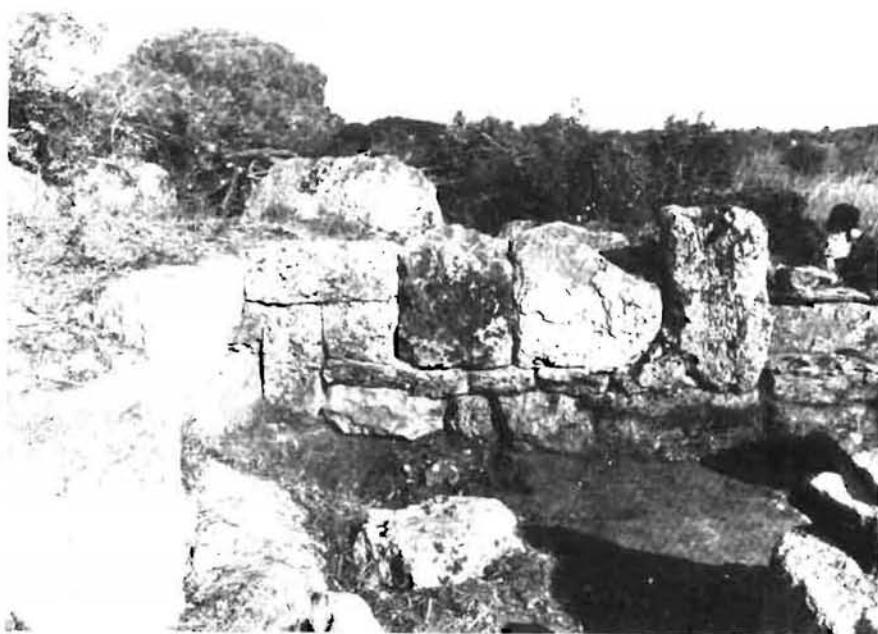
Detalles del portal de entrada desde el interior y uno de los paramentos internos.
