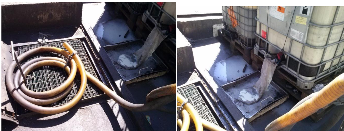
Slika 16: Zbirni jašek in prikaz dodajanja vode iz kubičnih zbiralnikov v jašek
