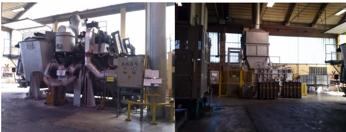
Slika 8: Talilni peči na lokaciji 2
