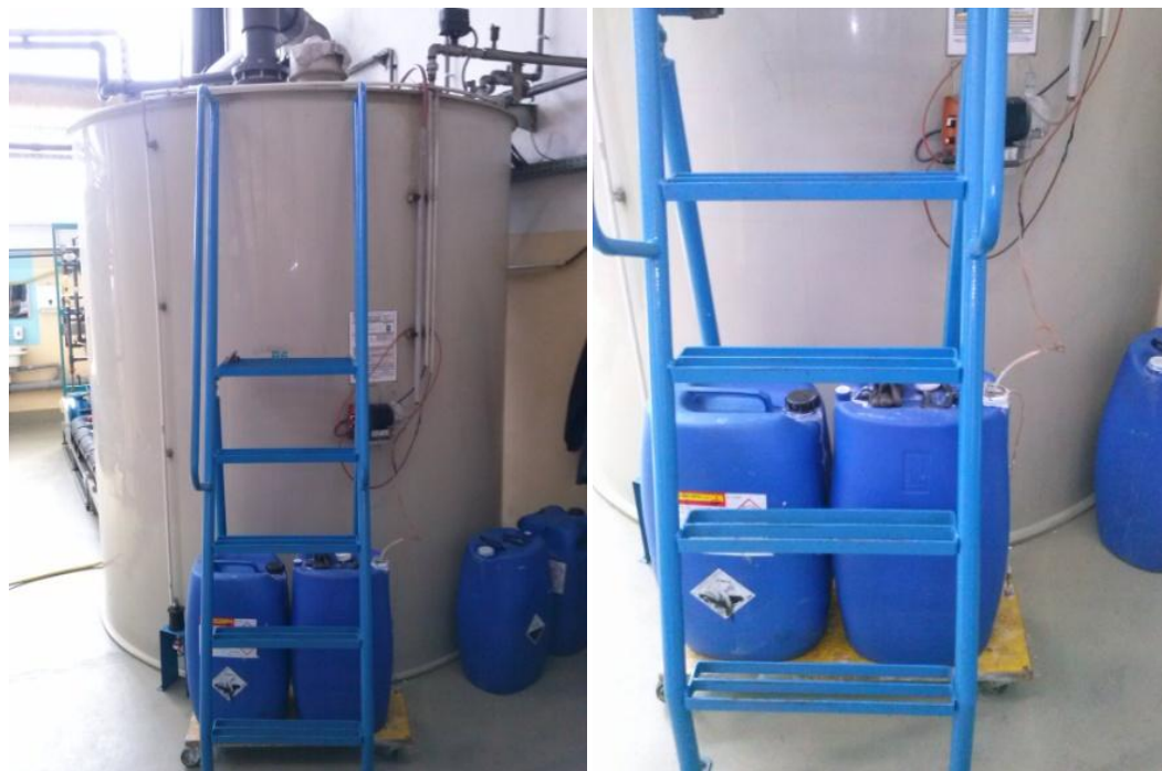
Slika 20: Delovna posoda B6 in sodi, povezani z dozirno črpalko
