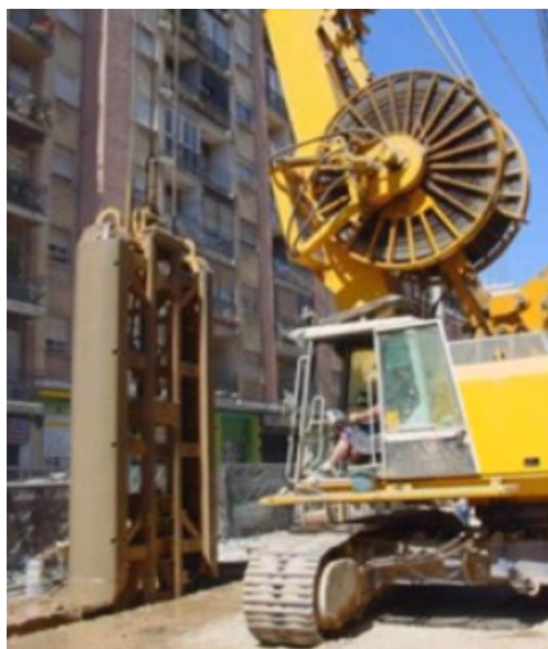
Slika 9: Bagrski izkop kanala z grabežem (vir: http://www.terratest.com/ )
