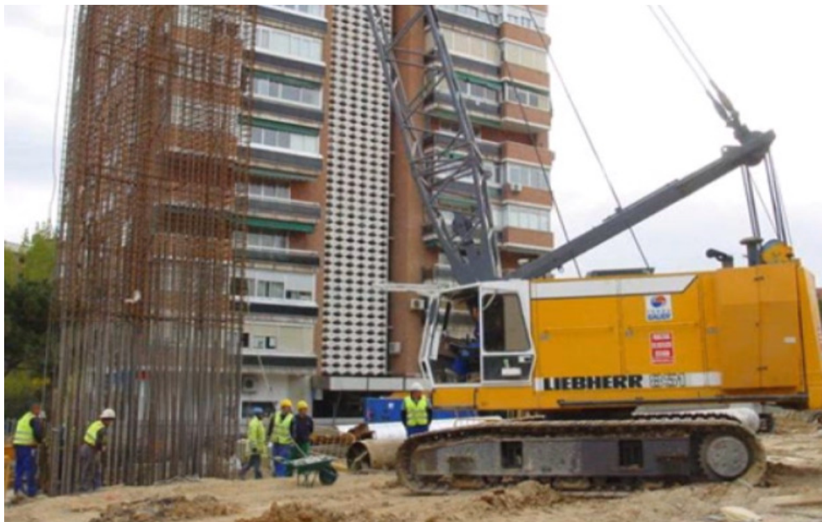
Slika 10: Spuščanje armaturnega koša v jašek (vir: http://www.terratest.com/ )
