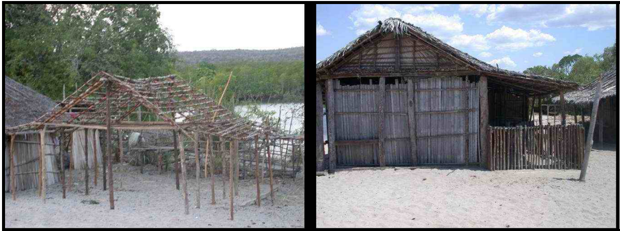
Figure 20 : Les bois de palétuviers dans la construction de maison (Photos : C. Andriamalala)
