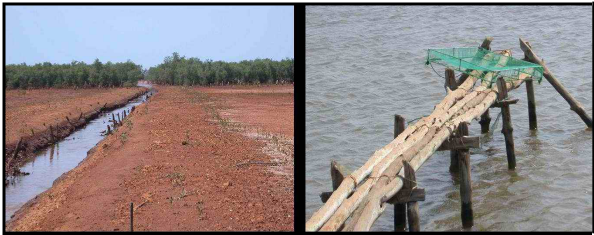
(1) Canalisation dans la zone d'aquaculture
