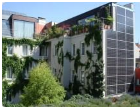
Figuur 5.1 Boutique-Hotel Stadthalle Wien. Behalve van zonnepanelen voor de opwekking van elektriciteit maakt dit hotel gebruik van muurverwarming.
