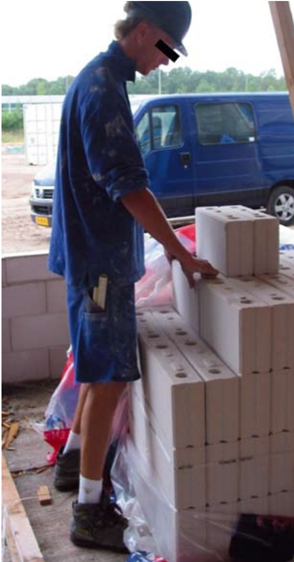
Afbeelding 3. Werkplek op de bouw waar metingen met de rolmaat werden uitgevoerd
