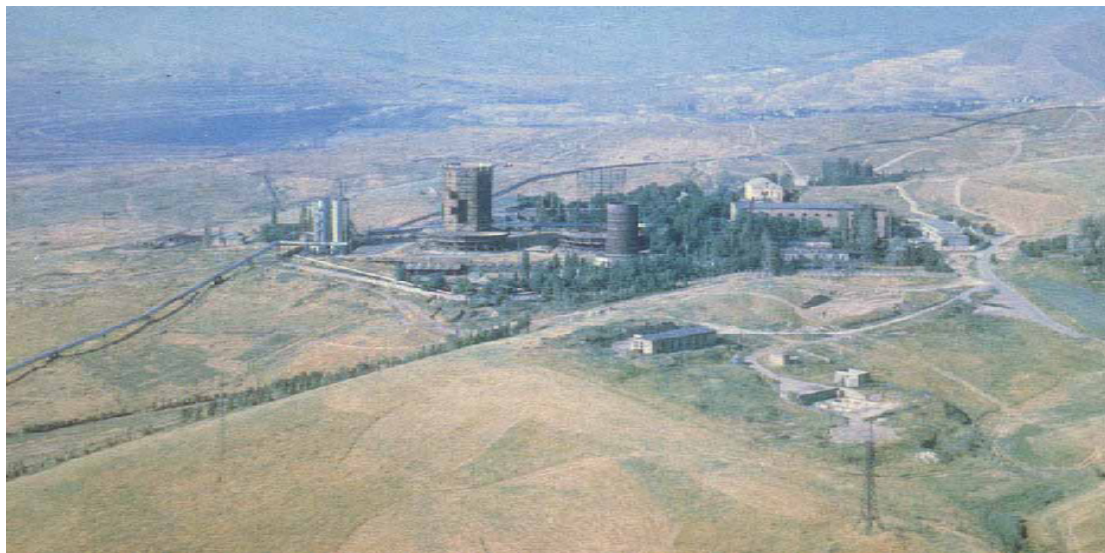
Рисунок 1.7 – Дільниця Ангреньської станції «Підземгаз» (1997 р.)
