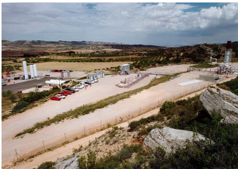
Рисунок 1.13 – Експериментальна ділянка в Теруелі: зліва нагнітальний комплекс, у центрі диспетчерська, справа газовідвідний комплекс
