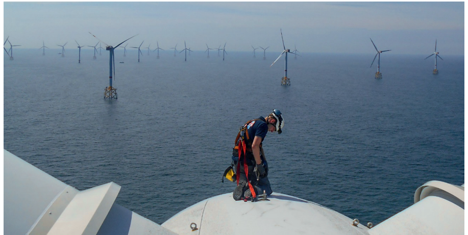
Gedurende gemiddeld 85% van het jaar draaien windturbines effectief en produceren ze dus stroom. Onder andere tijdens het onderhoud, zoals hier bij de inspectie van de wieken door een techniker, liggen de turbines stil. ©C-Power
