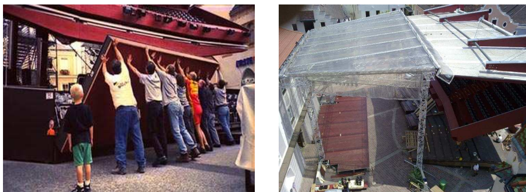
Abbildung 20: Klappbare Tribümenteile / vollständige Tribünenüberdachung
