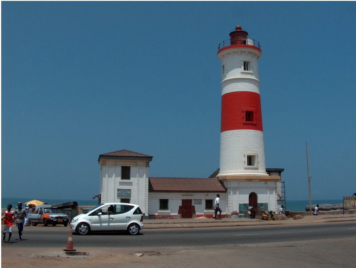
Abbildung 13 [Der Leuchtturm ©K.R.]
