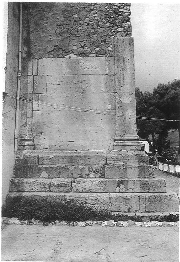
Fig. 13.—Vista del monumento en su estado actual.
