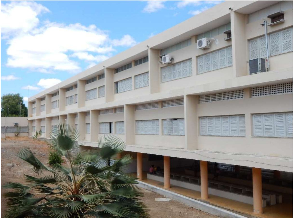
Figura 72 - Vista frontal do Bloco B (conectado ao Bloco C).
