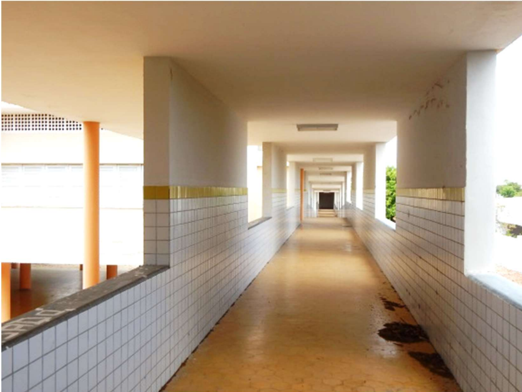
Figura 77 - Vista da passarela entre o Bloco A e o Bloco B, em nível superior.
