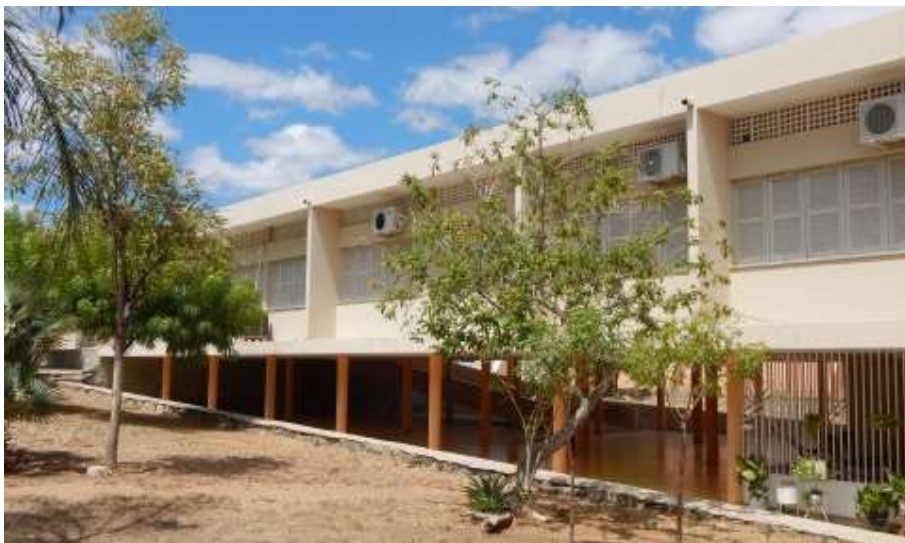
Figura 93 - Vista lateral do Bloco D (Fachada Leste).
