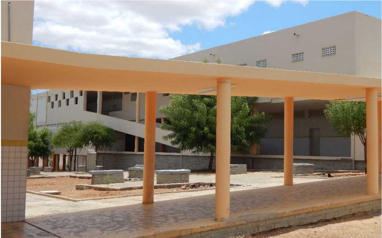
Figura 73 - Vista lateral do Bloco B (conectado por meio de passarela ao Bloco C).
