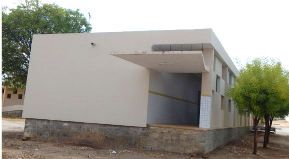
Figura 89 – Vista lateral do Bloco E (Fachada Oeste).
