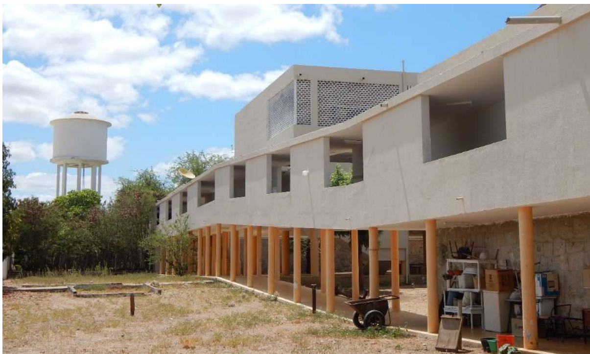
Figura 92 – Passarela coberta (Fachada Norte) que conecta os blocos A, B, D e ginásio.
