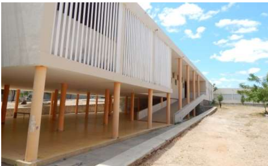
Figura 94 - Vista lateral do Bloco D – Fachada (Oeste).
