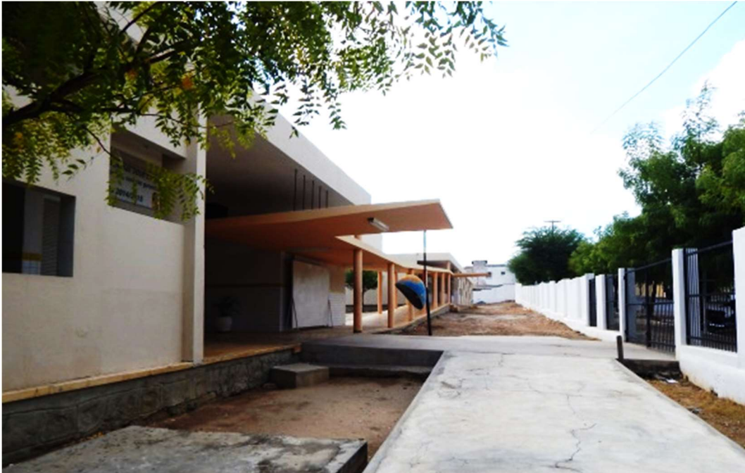
Figura 84 - Vista do Bloco E interligado ao Bloco C por meio da passarela coberta.
