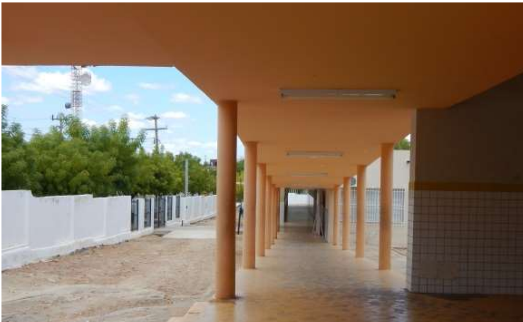
Figura 85 - Vista interna da passarela coberta entre os Blocos C e E.
