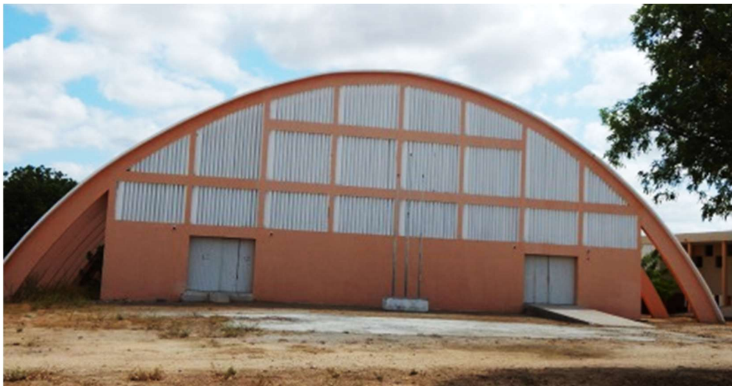
Figura 99 - Vista frontal do bloco G (Ginásio esportivo).
