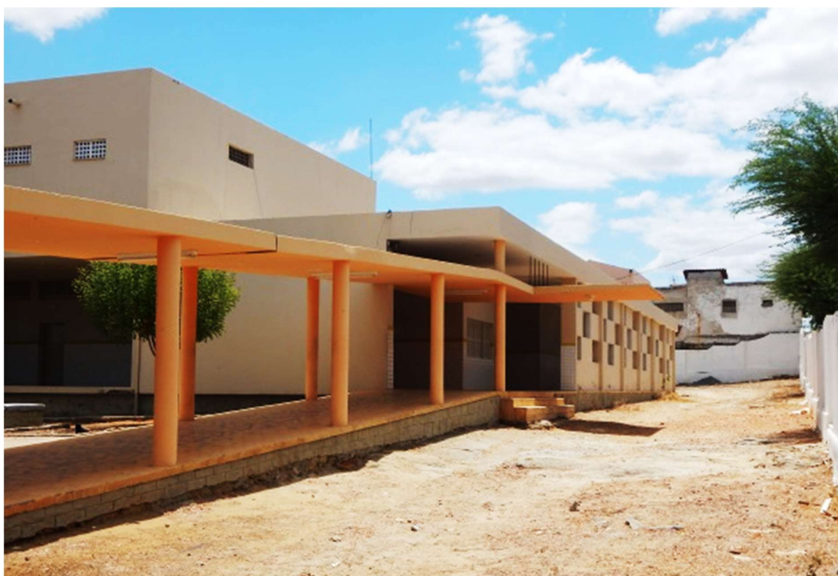
Figura 83 - Vista do Bloco C interligado ao Bloco E por meio da passarela coberta.
