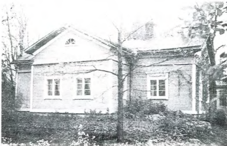
Pirkkalan Kaarilan päärakennus, joka on rakennettu 1700-luvun loppupuolella Pehr Adrian Gaddin hallitessa kotitilaansa. Gadd vietti kesiään Kaarilassa, missä hänellä oli myös koeputtarha. Kuva on otettu 1890-luvulla, ja rakennukset on purettu jo vuosikymmeniä sitten. Valok. Mauri Pesonen.
