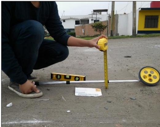
Grieta transversal y longitudinal que atraviesa la calzada, severidad media.
