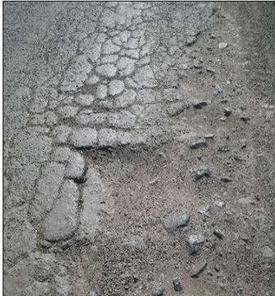
Falla tipo Grieta de cocodrilo de severidad alta con pérdida de material, en área sujeta a tránsito.
