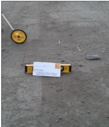
Depresión de severidad alta con desprendimiento de de agregados y material ligante.
