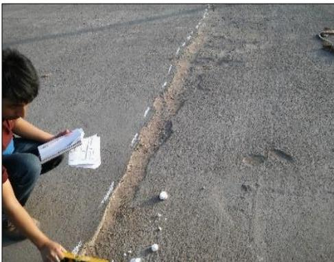
Grieta transversal de severidad alta con e > 150 mm de una longitud > 2.50m.
