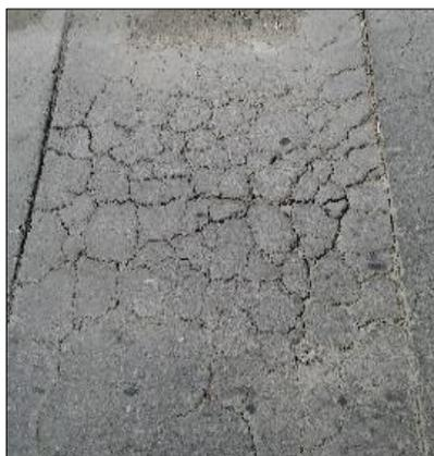
Parcheo con piel de cocodrilo de alta severidad con grietas de  $e < 25.4$  mm,
