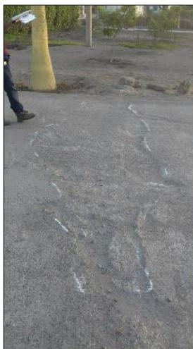
Desprendimiento de agregados en gran área de la calzada, acompañado de huecos de profundidad < 50.8 mm.
