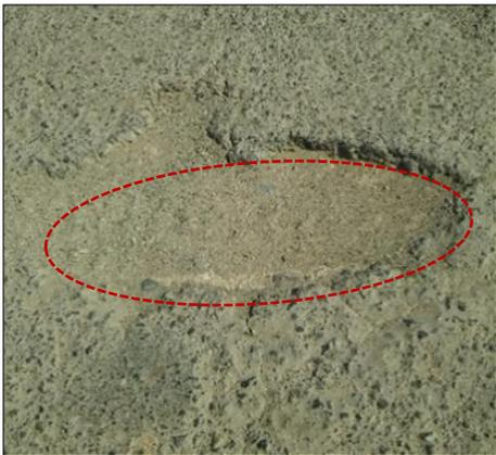
Huevo de severidad alta con profundidad < 50.8 mm y diámetro < 762 mm.
