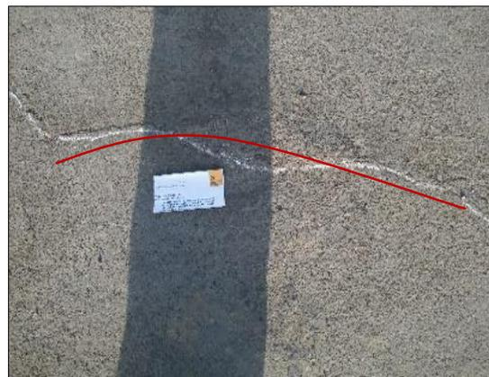
Grieta parabólica de severidad baja, sin agrietamiento significativo que afecte la calidad de tránsito.
