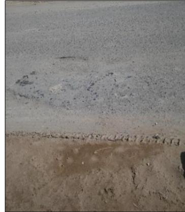
Huecos de alta severidad, con exposición y desprendimiento de agregados.
