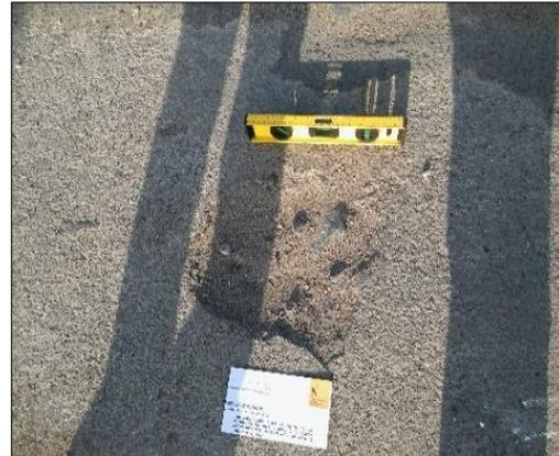
Hueco de severidad media, diámetro > 400mm. También se aprecia desprendimiento de material.
