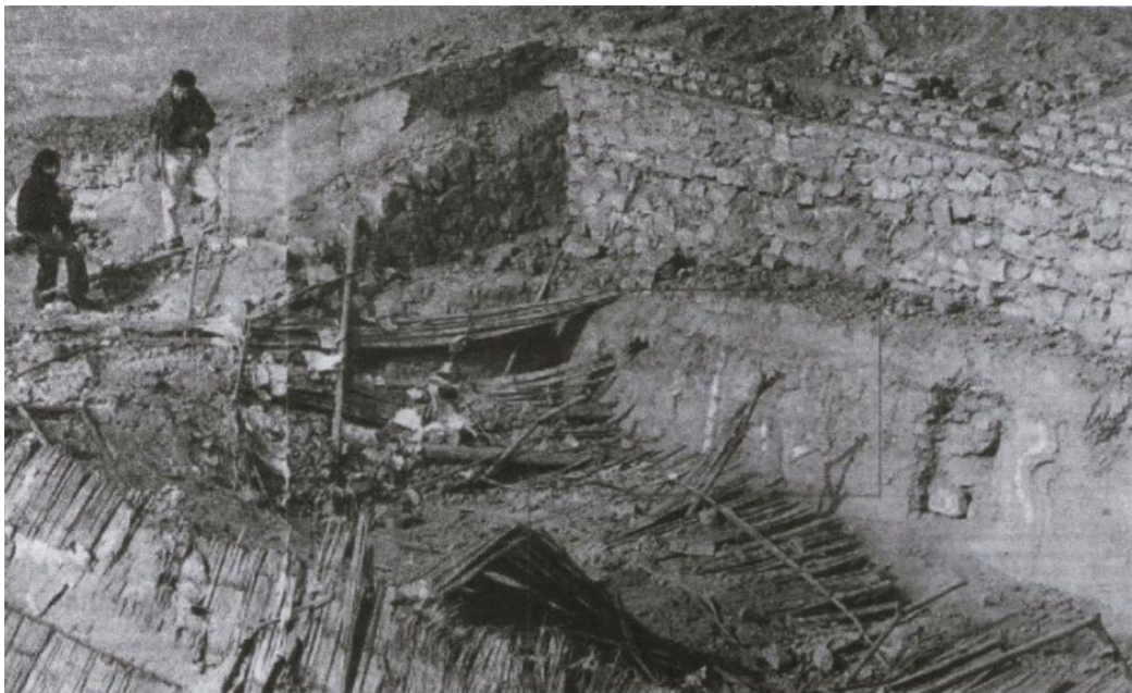
Imagen 81: Colapso del recinto protector del atrio central
