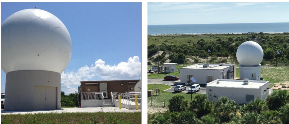
Fig. 3 (a) Kennedy Uplink Station (KUS) and (b) Ponce de Leon (PDL)
