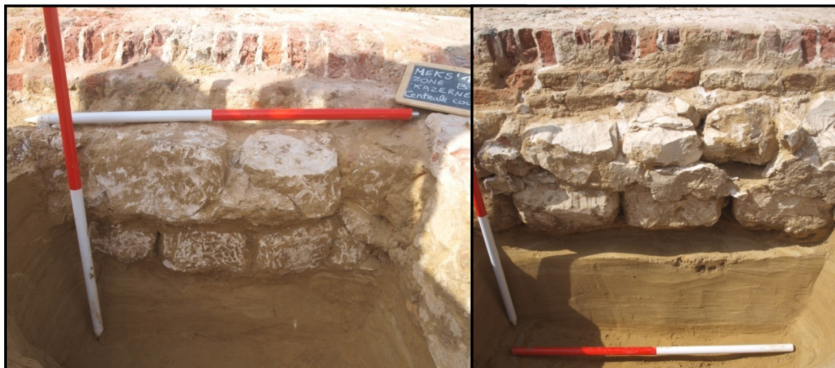
Figuur 32: Funderingsopbouw van de opslagplaats.
