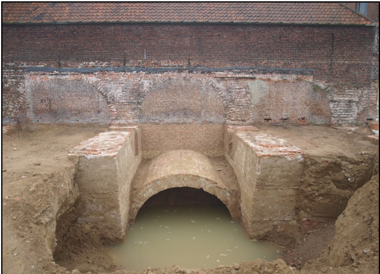
Figuur 23: Zicht op kazemat 2, met in de muur de negatiefsporen van de bovenste kazematten 1, 2 en 3.
