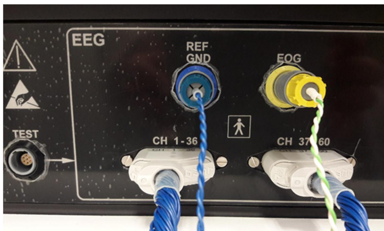
KUVA 14. Elektrodijohdot liitetty EEG-laitteeseen mittauksen aloittamista varten
