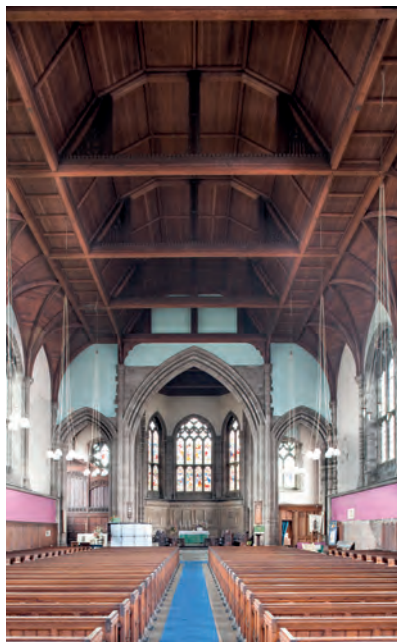
Bild 11. All Souls, interiören före ombyggnad. Foto: CCT, 2009.
